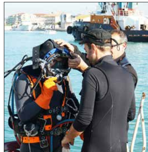
Onderwatermetselaars maken dagen tot maximaal acht uur onder water. Twee man houden permanent toezicht en geluidcontact. Activiteiten en apparatuur tot en met de duikuitrustingen worden beheerd via Carl Source. Internationale wetgeving vereist voor deze activiteiten ook nog een papieren logboek.
