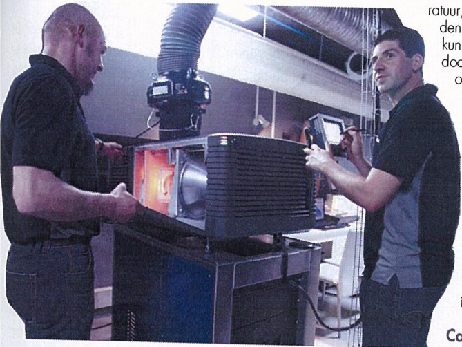
Na een oproep van de hostesses aan de installaties krijgen technici 15 minuten om ter plaatse te geraken en 15 minuten om de technische panne te herstellen
